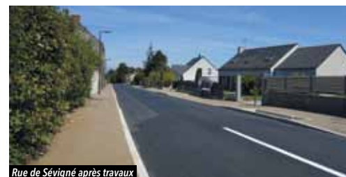
Rue de Sévigné après travaux
