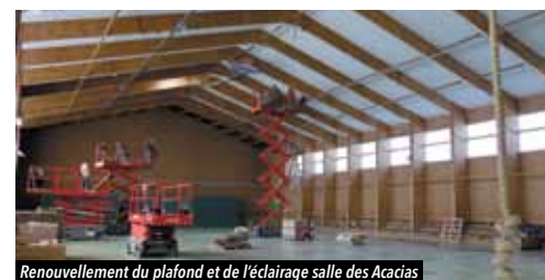
Renouvellement du plafond et de l'éclairage salle des Acacias
