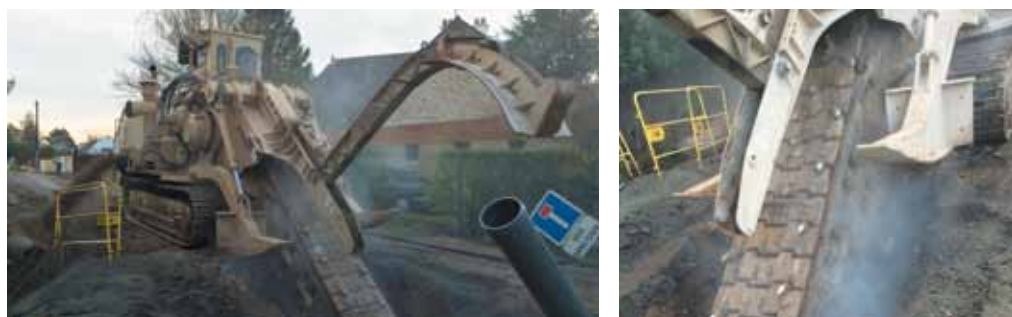
Les travaux d'extension du réseau d'assainissement se sont achevés mi-janvier au village de La Bouvardière. Ces travaux vont permettre à une cinquantaine d'habitations d'être raccordées au réseau d'assainissement collectif.
